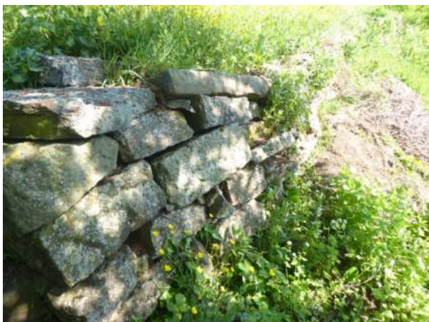
Abb. 19: Nicht von Vegetation überzogener Teil der Trockenmauer (Biotop).
